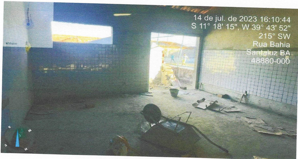
Foto 20 - Pastilha ceramica esmaltada, 5 x 5 cm, marca ATLAS, série metalo, cor cinza escuro, ref.Niquel - B-2104, aplicada com argamassa industrializada ac-ii, rejuntada, exclusive emboço (ou similar)
