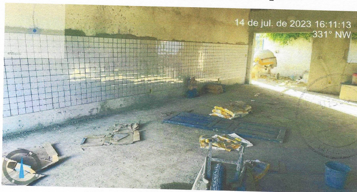
Foto 20 - Pastilha ceramica esmaltada, 5 x 5 cm, marca ATLAS, série metalo, cor cinza escuro, ref.Niquel - B-2104, aplicada com argamassa industrializada ac-ii, rejuntada, exclusive emboço (ou similar)
