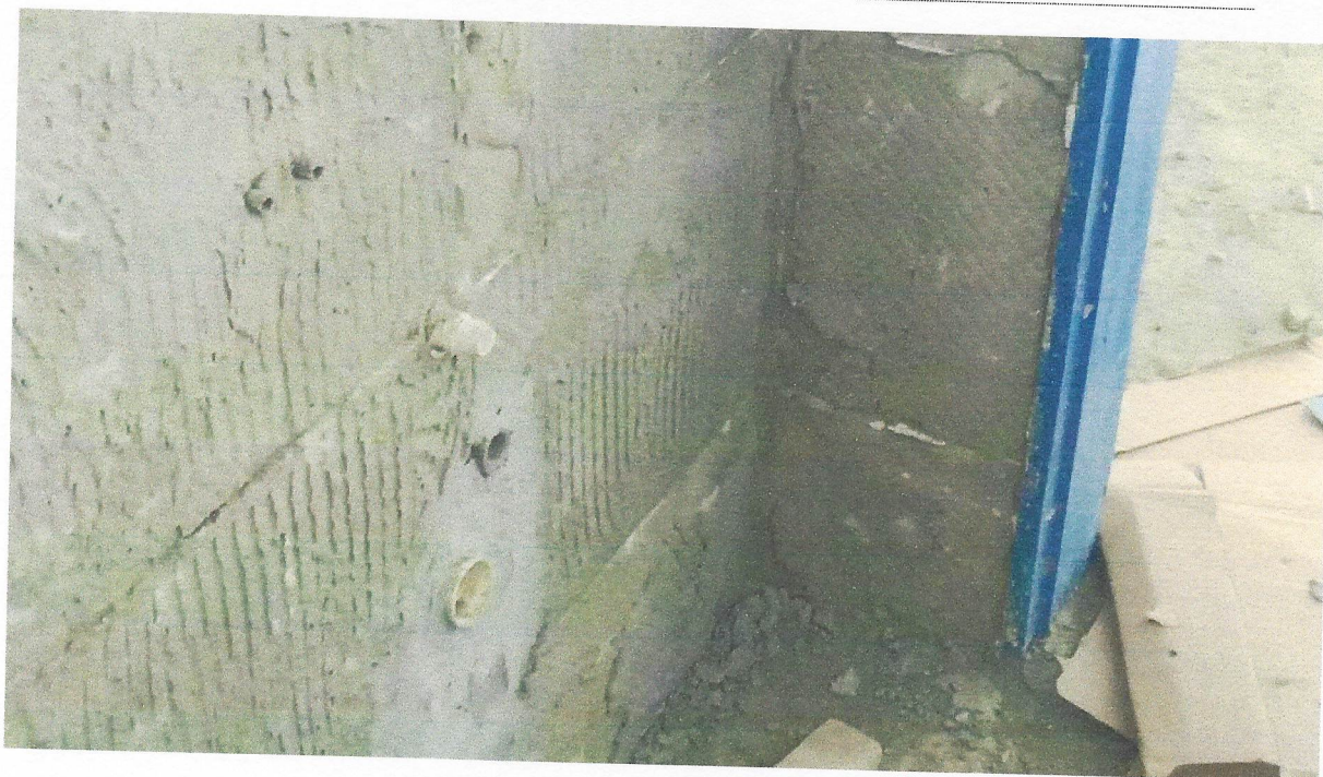
Foto 11 - TUBO PVC, SERIE NORMAL, ESGOTO PREDIAL, DN 40 MM, FORNECIDO E INSTALADO EM RAMAL DE DESCARGA OU RAMAL DE ESGOTO SANITÁRIO. AF_12/2014
