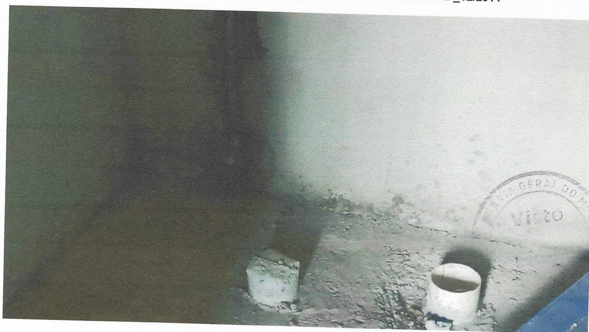
Foto 12 - RALO SIFONADO, PVC, DN 100 X 40 MM, JUNTA SOLDÁVEL, FORNECIDO E INSTALADO EM RAMAL DE DESCARGA OU EM RAMAL DE ESGOTO SANITÁRIO. AF_12/2014
