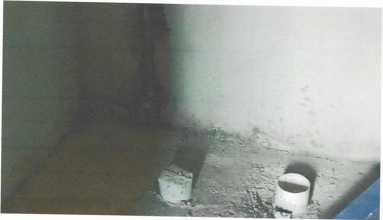
Foto 05- PONTO DE CONSUMO TERMINAL DE ÁGUA FRIA (SUBRAMAL) COM TUBULAÇÃO DE PVC, DN 25 MM, INSTALADO EM RAMAL DE ÁGUA, INCLUSOS RASGO E CHUMBAMENTO EM ALVENARIA. AF_12/2014
