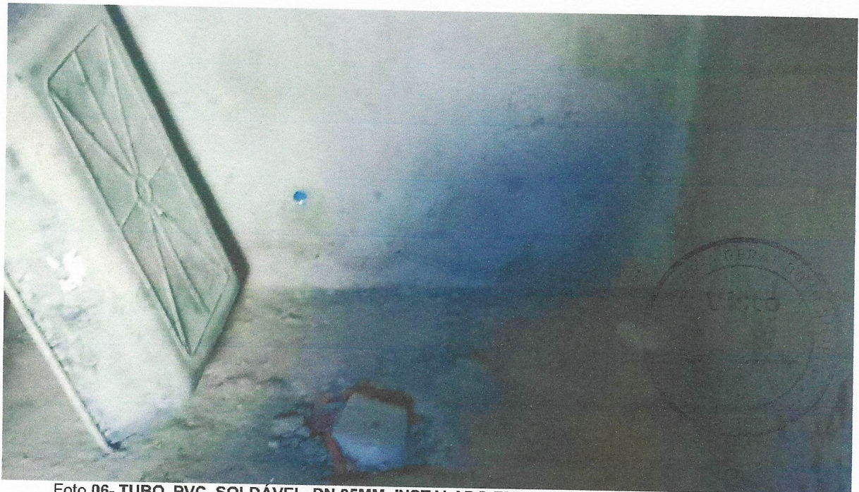
Foto 06- TUBO, PVC, SOLDÁVEL, DN 25MM, INSTALADO EM RAMAL OU SUB-RAMAL DE ÁGUA - FORNECIMENTO E INSTALAÇÃO. AF_12/2014
