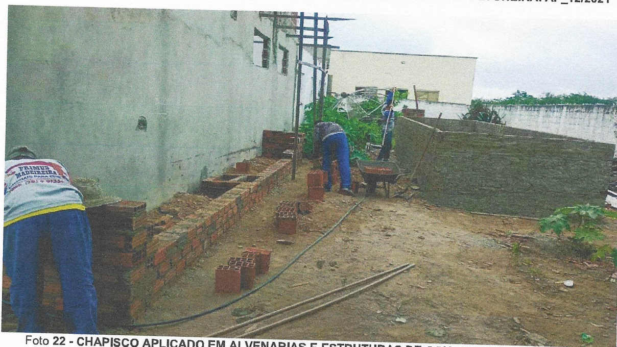
Foto 21 - ALVENARIA DE VEDAÇÃO DE BLOCOS CERÂMICOS FURADOS NA VERTICAL DE 9X19X39 CM (ESPESSURA 9 CM) E ARGAMASSA DE ASSENTAMENTO COM PREPARO EM BETONEIRA. AF_12/2021
