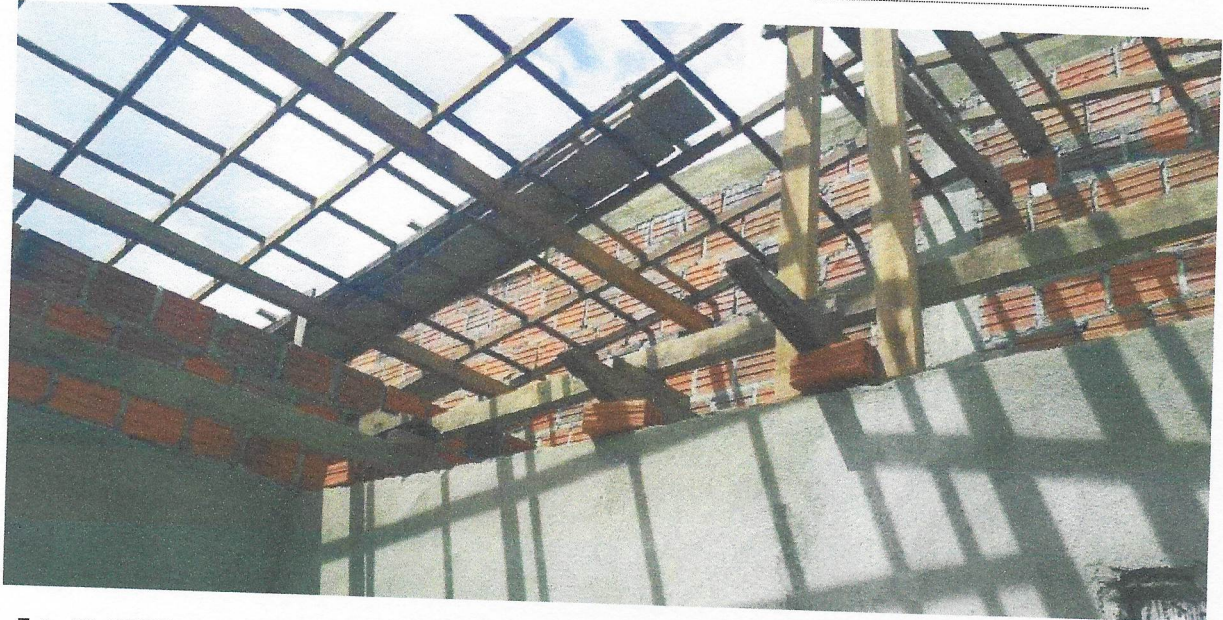
Foto 03- RETIRADA E RECOLOCAÇÃO DE RIPA EM TELHADOS DE ATÉ 2 ÁGUAS COM TELHA CERÂMICA CAPA-CANAL, INCLUSO TRANSPORTE VERTICAL. AF_07/2019
