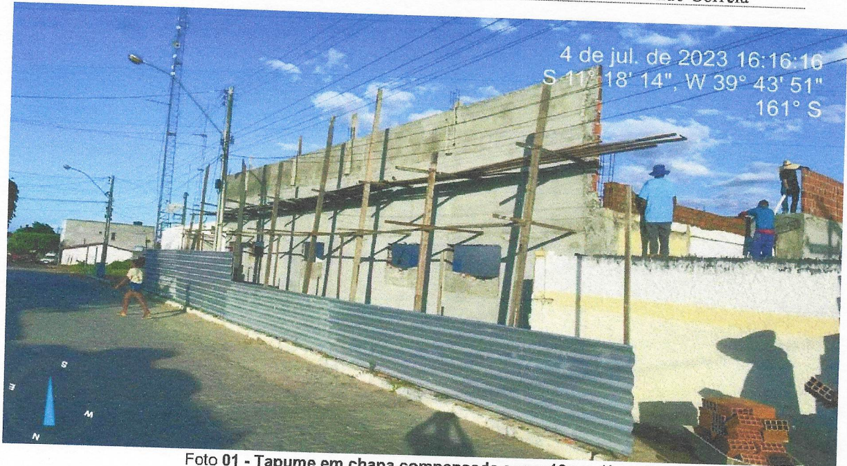
Foto 01 - Tapume em chapa compensada esp = 10mm (1 uso)
