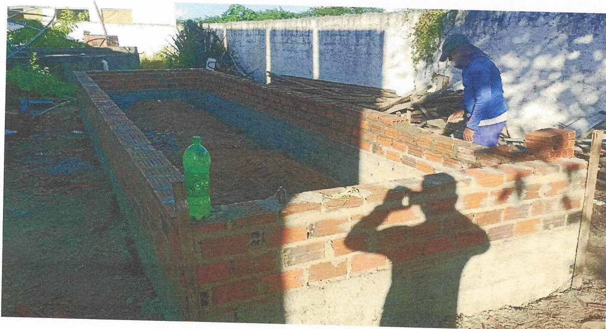
Foto 21 - ALVENARIA DE VEDAÇÃO DE BLOCOS CERÂMICOS FURADOS NA VERTICAL DE 9X19X39 CM (ESPESSURA 9 CM) E ARGAMASSA DE ASSENTAMENTO COM PREPARO EM BETONEIRA. AF_12/2021
