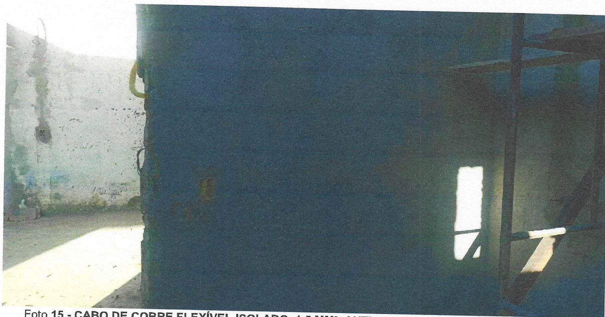
Foto 15 - CABO DE COBRE FLEXÍVEL ISOLADO, 1,5 MM 2 , ANTI-CHAMA 450/750 V, PARA CIRCUITOS TERMINAIS - FORNECIMENTO E INSTALAÇÃO. AF_12/2015
